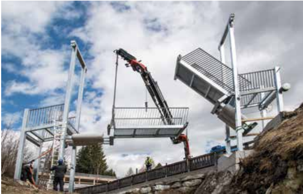
12 Einhub der nördlichen Brückenklappe © Stefan Ritzer's VD GmbH
