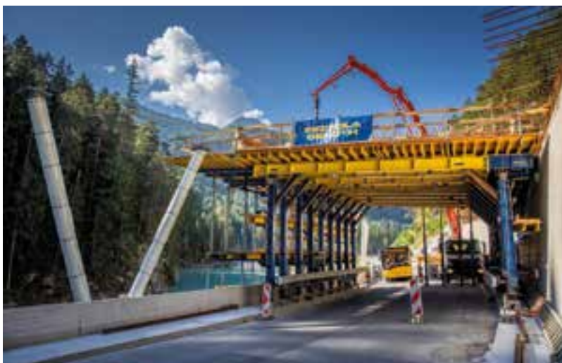
■ Einsatz zweier Tunnelschalwagen mit Jochträgern © Deutsche Doka Schalungstechnik GmbH
