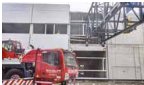
■ Aufnehmen, Anheben und Positionieren der vorgefertigten Stahlstruktur © Tadano Europe Holdings GmbH
