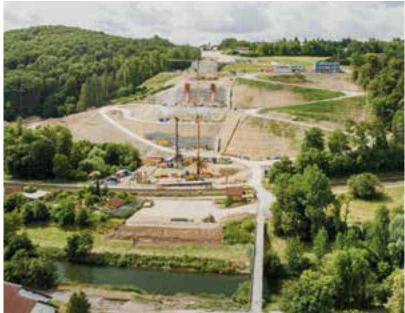
■ Baufeld kurz vor Abschluss der Spezialtiefbauarbeiten © Porr GmbH & Co. KGaA
