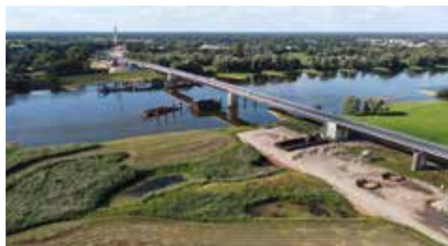
Errichtung der neuen Flussquerung parallel zur bestehenden © Implenia Construction GmbH/K+S Ingenieur-Consult GmbH & Co. KG
