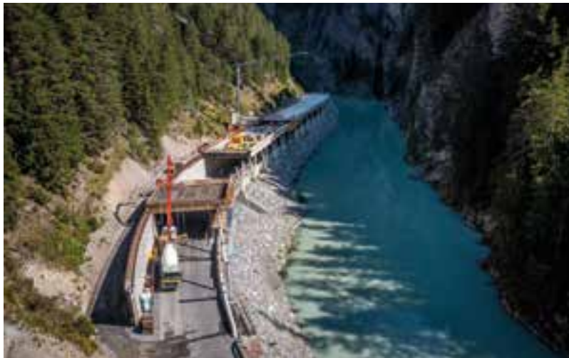
■ Errichtung des Bauwerks zwischen Berghang und Fluss © Deutsche Doka Schalungstechnik GmbH
