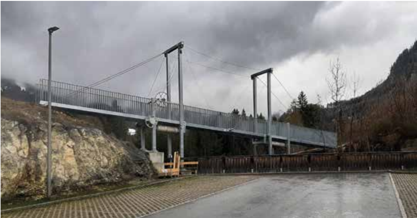
18 Längsansicht der fertiggestellten Zugbrücke © Toni Schmale
