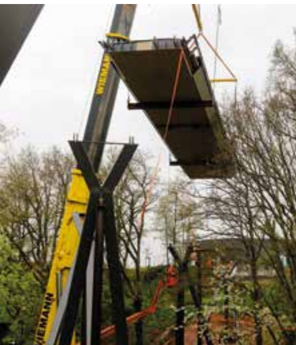
10 11 Einhub der Brücke überm Engelshaus © Joachim Swillus
