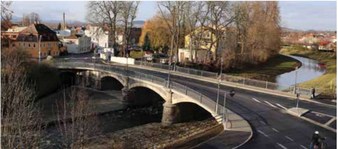
17 König-Albert-Brücke in Zittau © Landesamt für Straßenbau und Verkehr Sachsen
