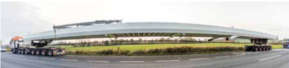
8 Sondertransport: Anlieferung des Überbaus © UTM-Transport-2022
