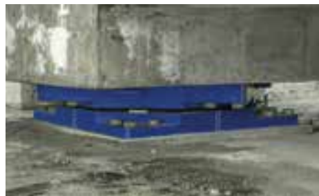
Lager nach Einbau unter einem Pfeiler © Maurer SE
