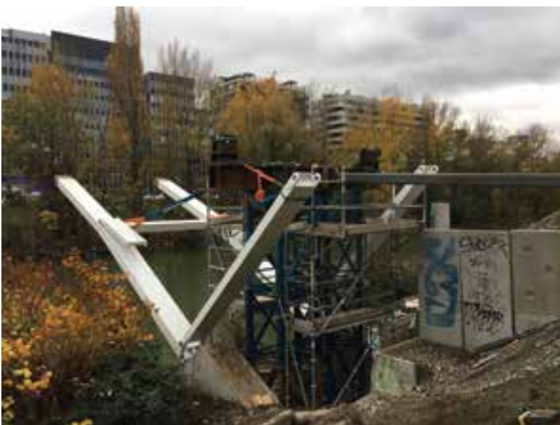
9 Montage von Bogen und Pfosten © tragwerkstatt ZT gmbh
