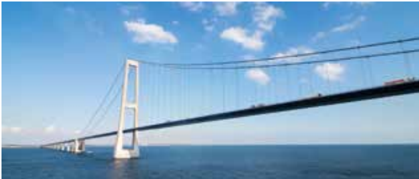
■ Storebaelt-Brücke mit Structural Health Monitoring © Kistler Instrumente AG
