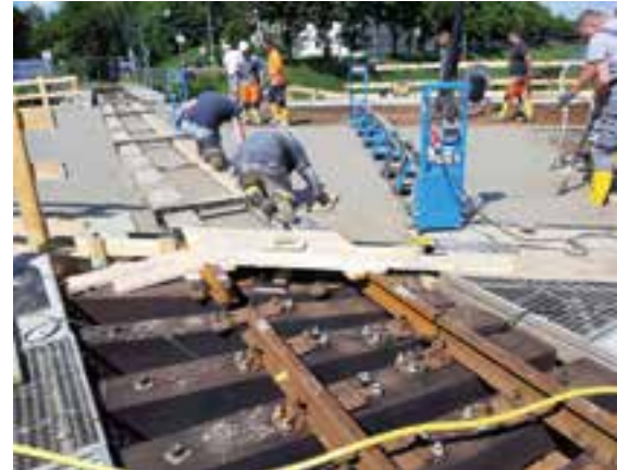
13 Betonage der Fahrbahnplatte am Schienentrog © Landesamt für Straßenbau und Verkehr Sachsen
