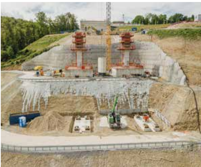
■ Errichtung der ersten Brückenpfeiler © Porr GmbH & Co. KGaA
