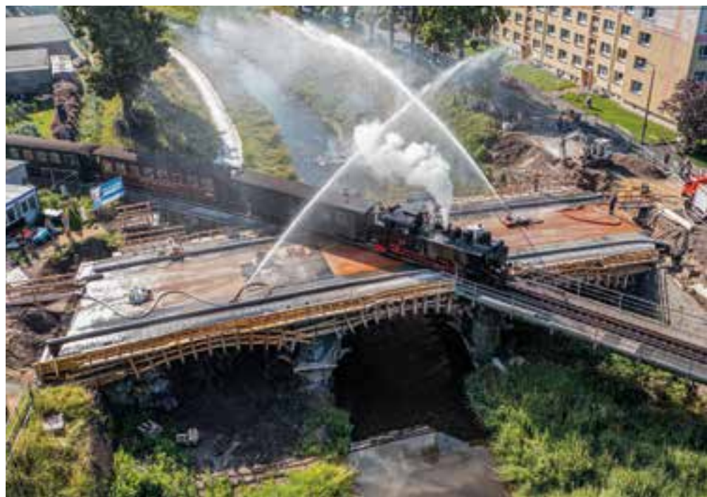
14 Erste Fahrplanüberfahrt am 1. Juli 2022 durch ein »Wassertor« © Landesamt für Straßenbau und Verkehr Sachsen
