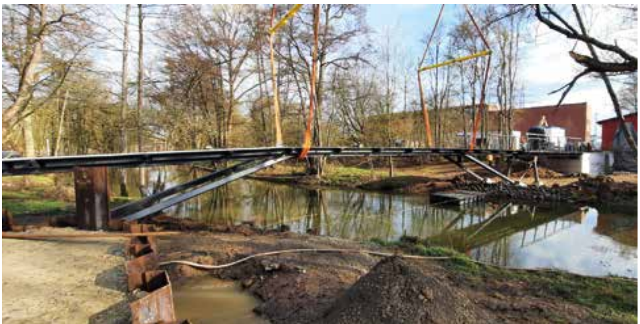
16 Bau des Stegs zur Hornungsmühle © Joachim Swillus
