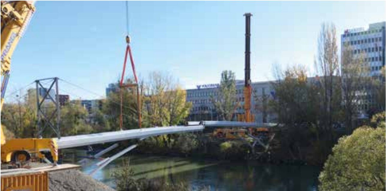
10 Einhub der Großbauteile © Porr Bau GmbH
