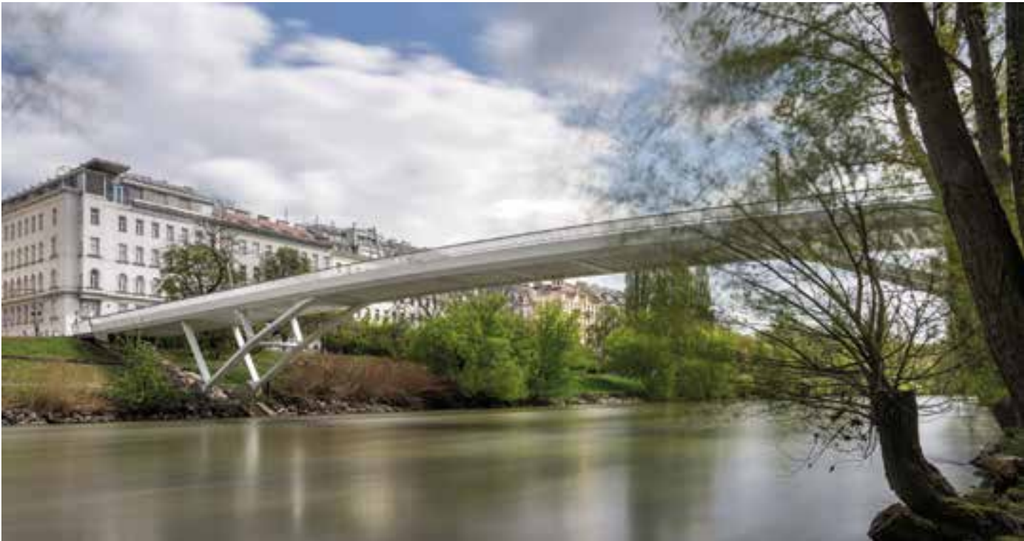
14 Transparenz durch den Verzicht auf Verbände © tragwerkstatt ZT gmbh
