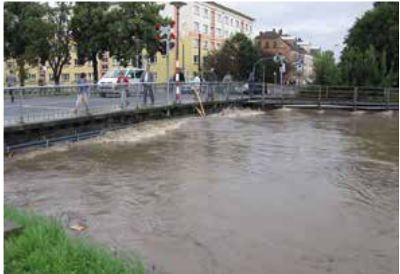
5 Mandau mit Hochwasser im Jahr 2010 © Landesamt für Straßenbau und Verkehr Sachsen
