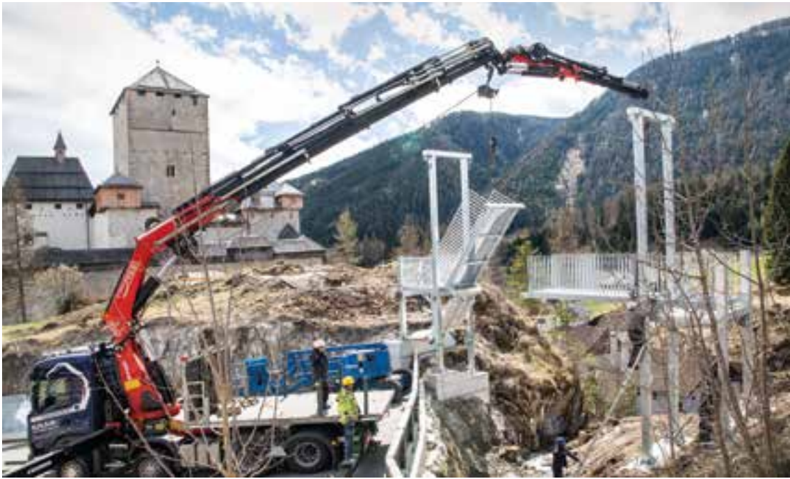
6 Errichtung der Zugbrückenkonstruktion © Stefan Ritzer's VD GmbH
