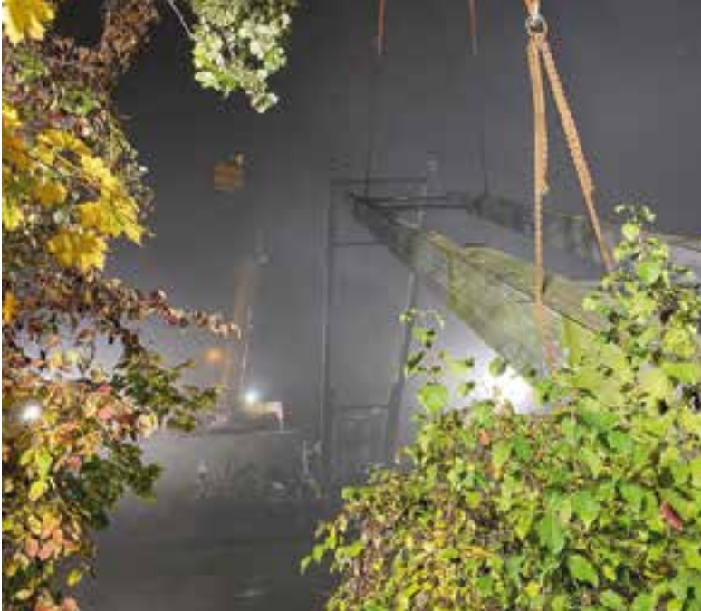
7 Demontage des alten Holzstegs © Porr Bau GmbH
