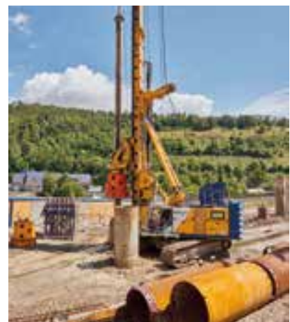
■ Einsatz von Drehbohranlagen © Porr GmbH & Co. KGaA
