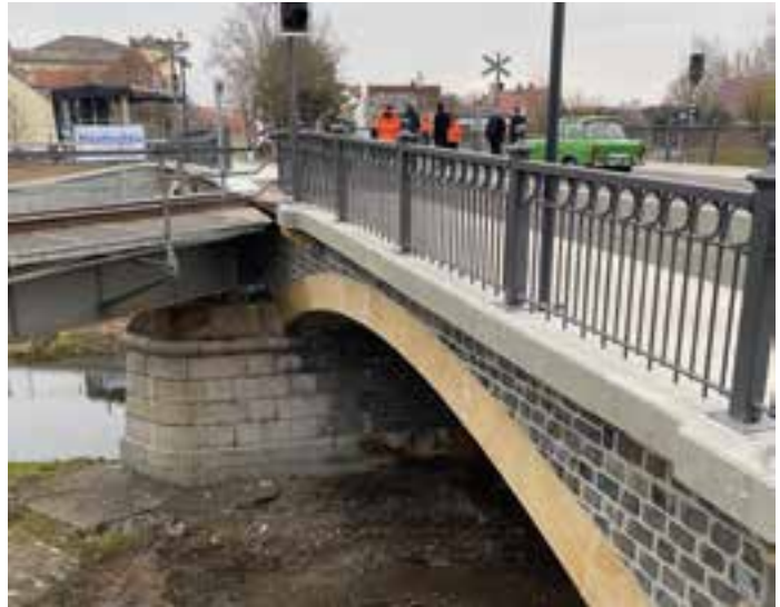
16 Teilansicht von Oberstrom nach Komplettierung © VIC Planen und Beraten GmbH
