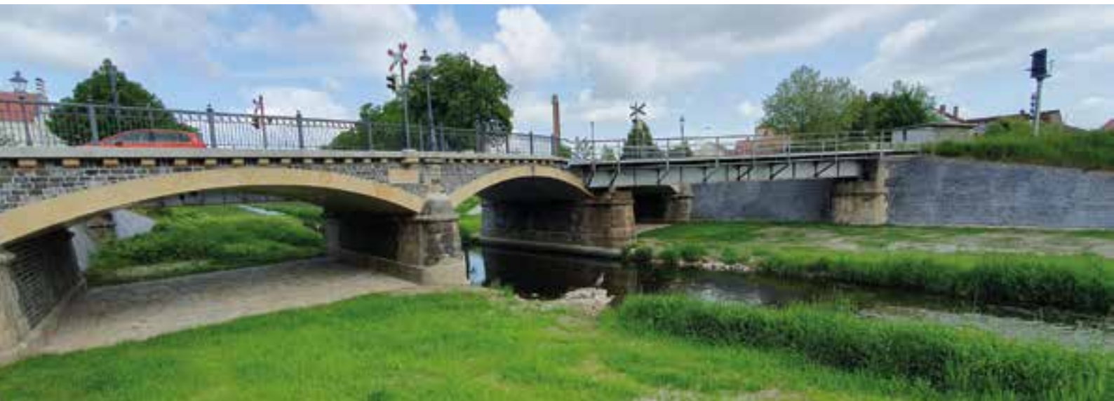
18 Prinz-Friedrich-August-Brücke in Zittau © Landesamt für Straßenbau und Verkehr Sachsen
