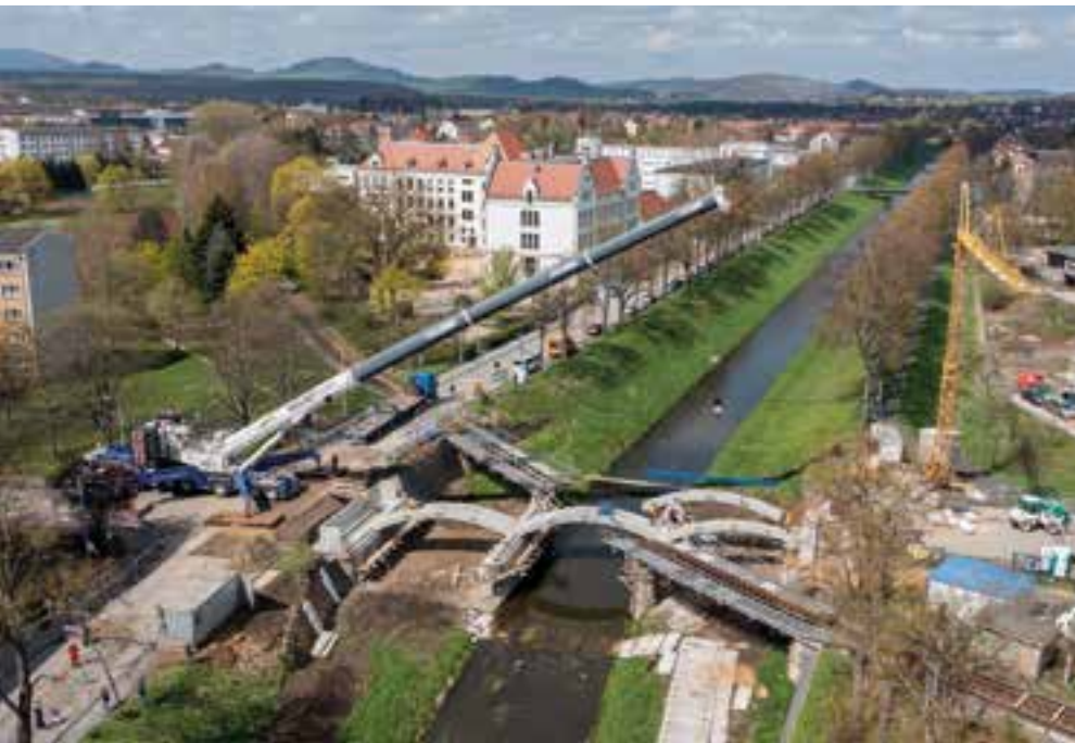
12 Fertigteilmontage am 28. April 2022 © Landesamt für Straßenbau und Verkehr Sachsen
