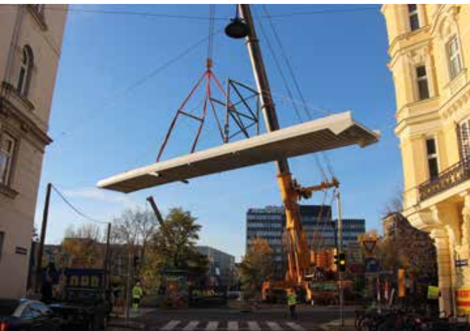
11 Absetzen der Überbauhälften mit Hilfsabspannung © tragwerkstatt ZT gmbh
