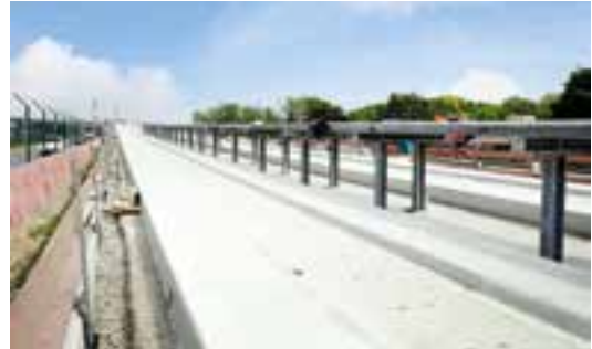
Betonfahrbahn mit integrierten Heizkabeln © Fraport AG/Heidelberg Materials AG
