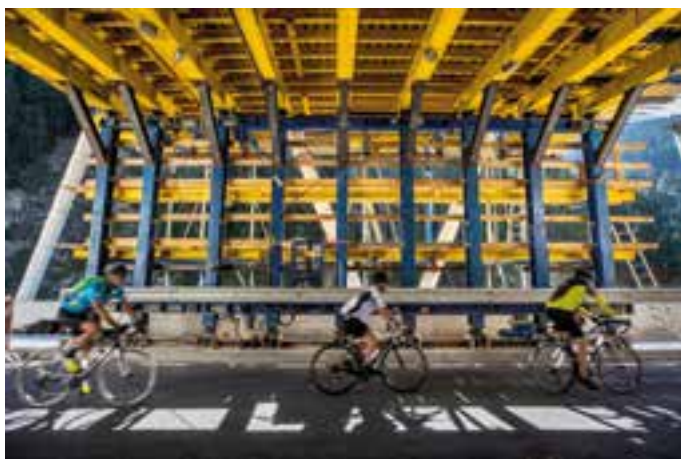
■ Uneingeschränktes Lichtraumprofil für den Verkehr © Deutsche Doka Schalungstechnik GmbH
