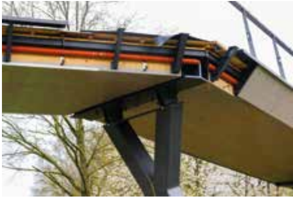
8 Brücke überm Engelshaus: Knickpunkt im Bauzustand © Joachim Swillus
