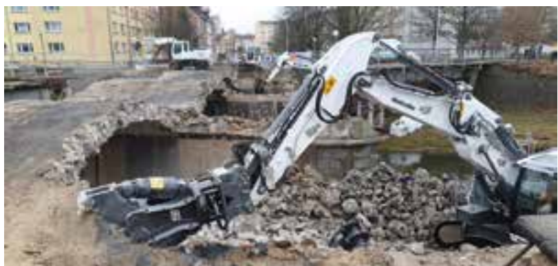
11 Streifenweiser Abbruch der drei Bögen © Landesamt für Straßenbau und Verkehr Sachsen
